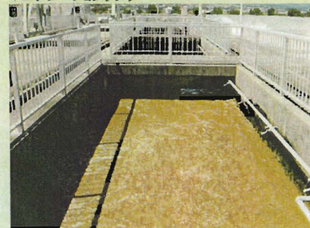
▼エアレーションタンク
