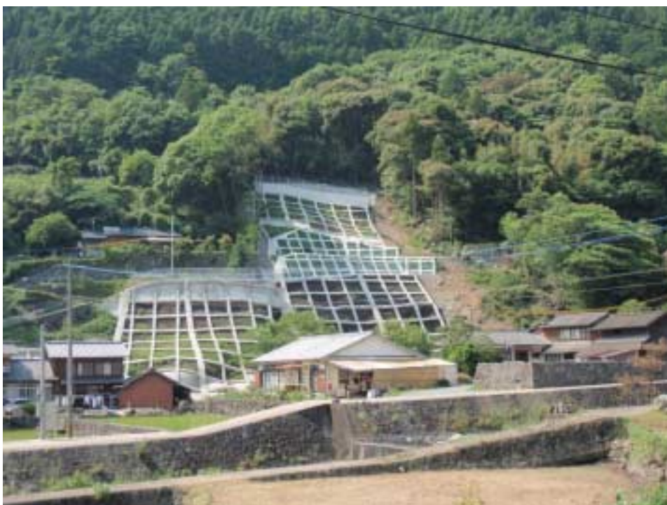
中島地区急傾斜地
