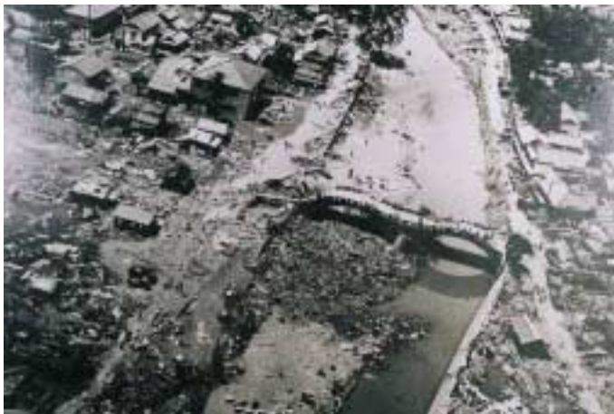
昭和３２年７月２５日 諫早大水害 本明川の氾濫による市中 心部の被災状況 （中央は眼鏡橋）
