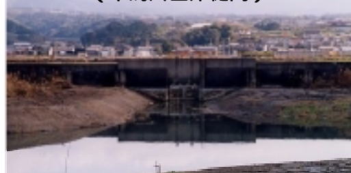
締め切り後の樋門の状況 (千鳥川左岸樋門)
