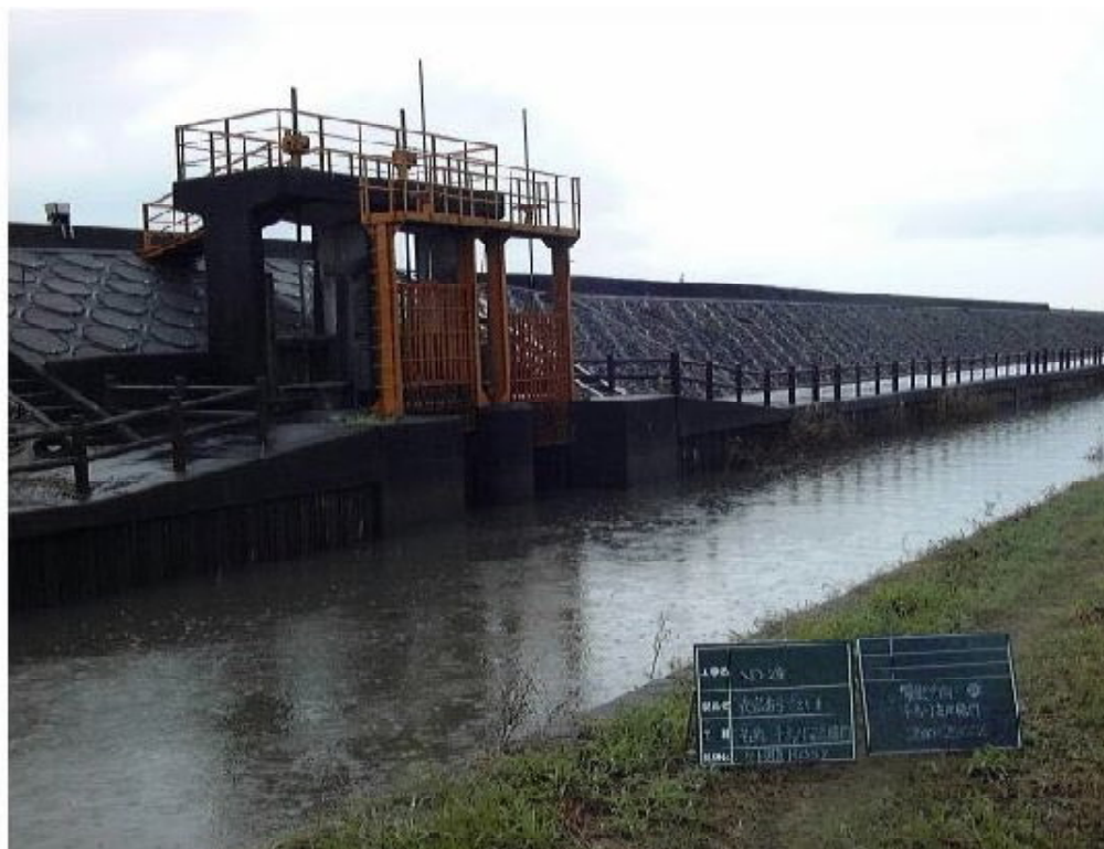
背後地の潮遊池（千鳥川左岸樋門）
