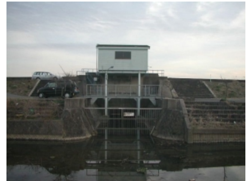
樋門全景(背後地から調整池側を望む)
